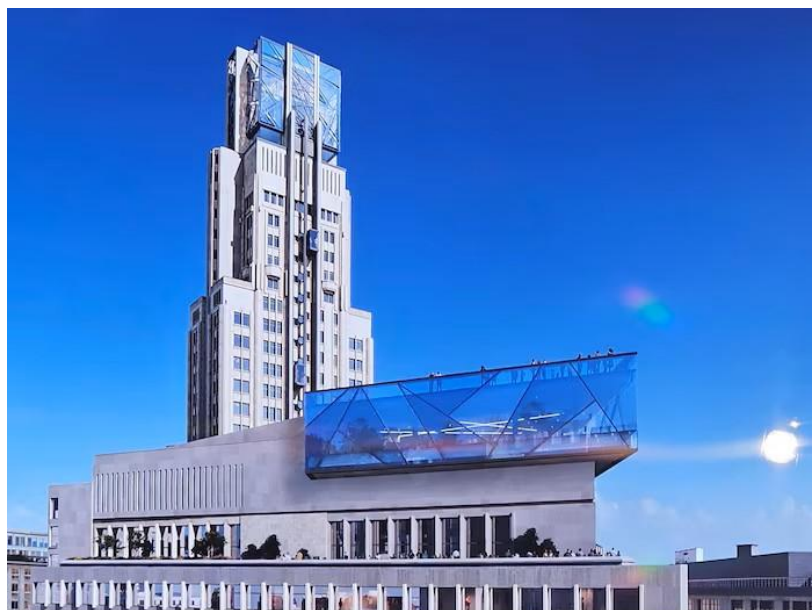
Tweede voorstel Verbouwing Boerentoren Antwerpen © Daniel Libeskind & Phoebus Foundation
