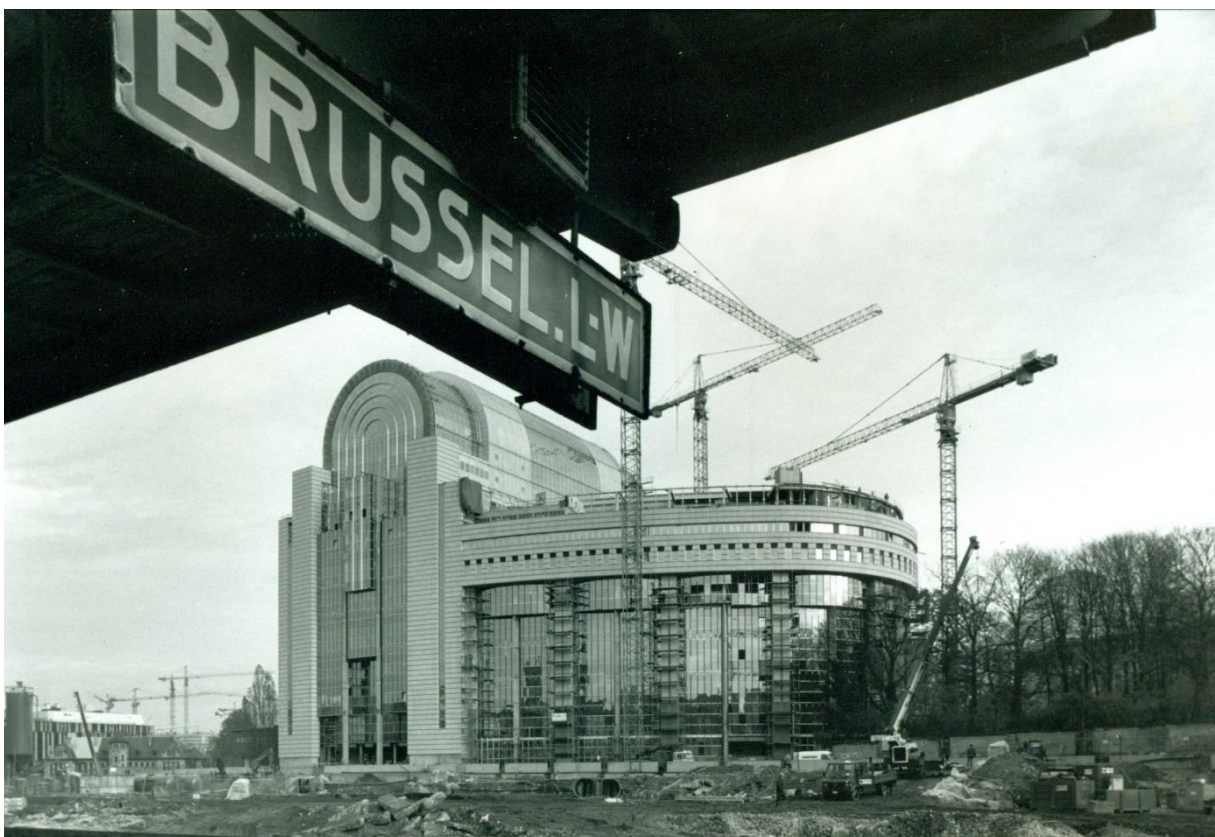
"Caprice des Dieux" in aanbouw. Foto Filip Claus
